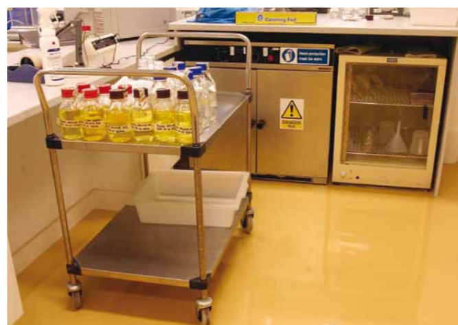
En selvsnivellerende fleksibel polyuretanbelægning. Til lettere industrier med krav til hygiejne og fleksibilitet.
