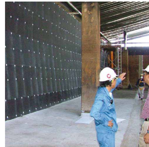
ATB-300® Honeycomb C polypropylenplader isolerer fra eksisterende underlag og muliggør påføring på vådt underlag. Anvendes kun i kombination med ATB-300® GL Laminat.
