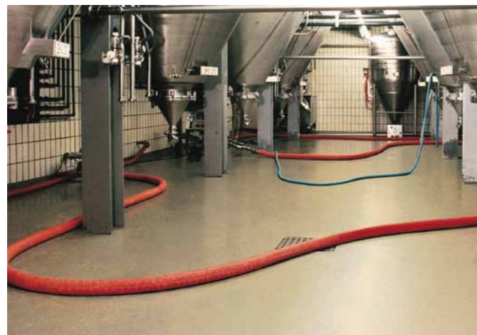
Flowfast akrylbelægninger er slidstærke og hurtighærdende. Modstår kraftig mekanisk, kemisk og termisk belastning.
