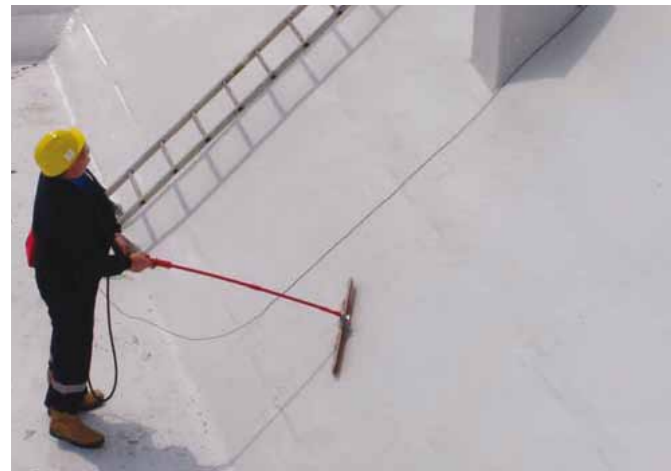
ATB-300® GL Laminat er en UV-resistent vinylester med glasfibernæv. Kan påføres manuelt med glasfibernætter eller spraypås.
